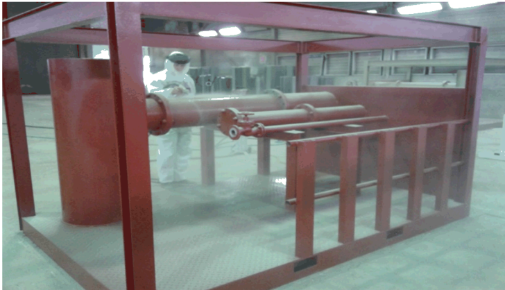
Dimensie nevel uitbreiding (stralen op testopstelling)
